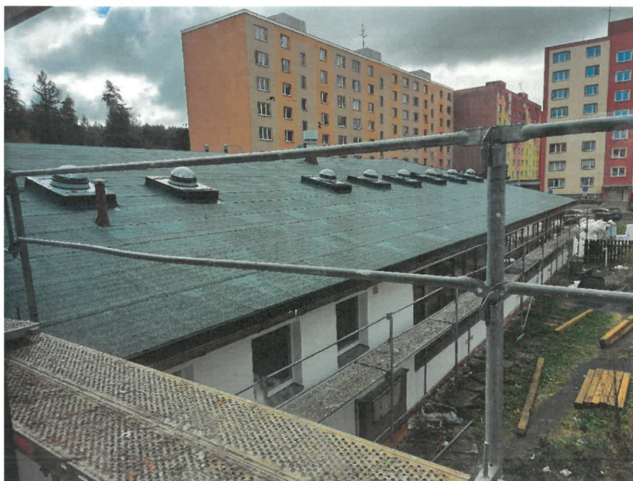
Nová střecha a světlovody na školní jídelně.
