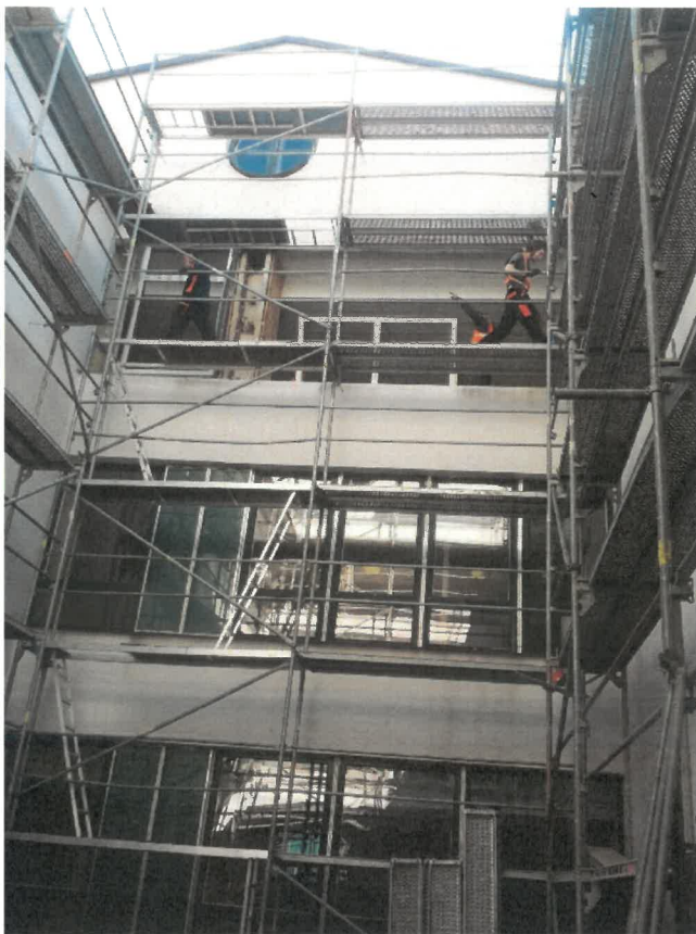
Výměna oken ve vnitřním atriu (prázdniny).
