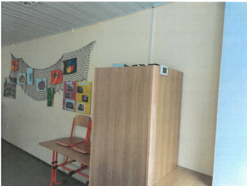
Vzduchotechnická jednotka ve třídě vč. digitálního ovladače
